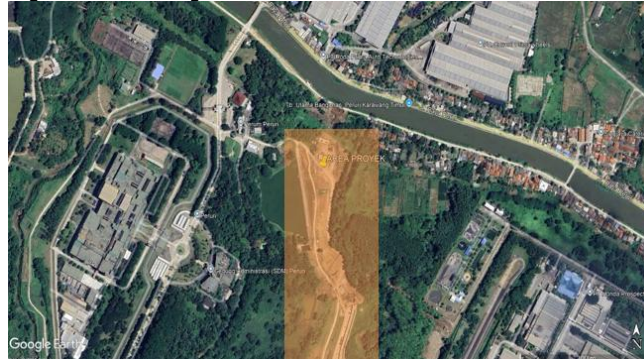
Gambar 3 Detail Lokasi Penelitian Sumber: Data Proyek Konstruksi
