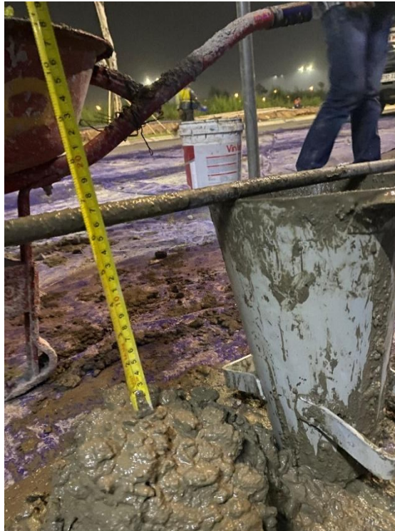
Gambar 10 Pengujian slump test
