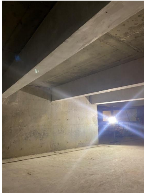
Gambar 5 Balok Setelah Bekisting Dibongkar
