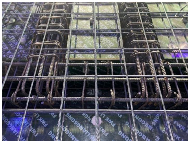
Gambar 4 Penulangan Balok
